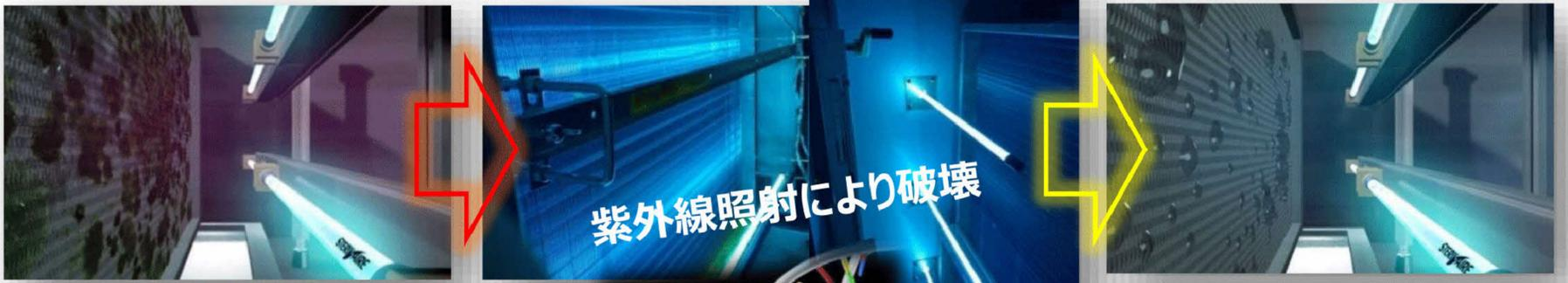
コイルにバイオフィームが形成された時には、既にコイルフィン内部は汚染されています。コイルに紫外線UV-Cを照射することにより、汚染を継続的に防ぐことができます。
